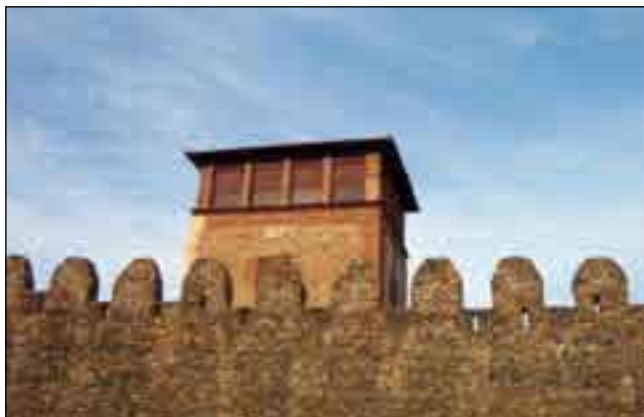
Torreón y muralla medieval restaurada en el 2007
