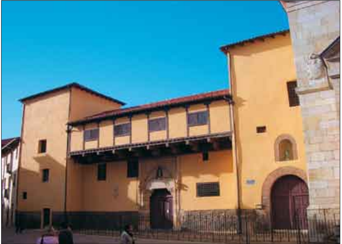
Fachada principal del Convento
